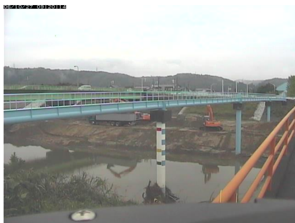
図 4. 2-12 嶺崎橋設置の Web カメラ映像
