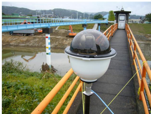
写真 A6-4 検証課題1 刈谷田川に設置されたWebカメラ 出典C
